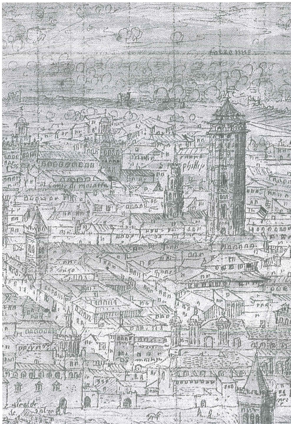
FIGURA 1. La Torre Nueva de Zaragoza en relación con su entorno urbano. [Fragmento de la Vista de Zaragoza; Antón Van den Wyngaerde, 1563]
