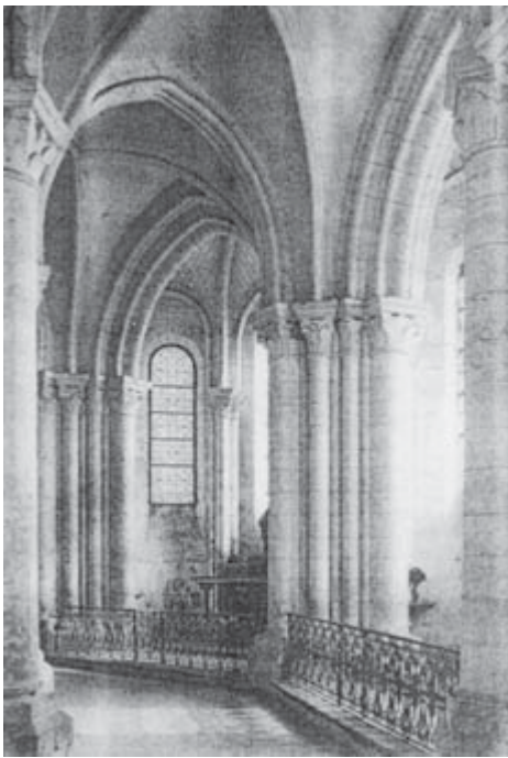
Fotos 1 y 3.—El deambulatorio de St. Denis (1) empezado en 1140, obedece a la misma concepción estructural que el de St. Germer-de-Fly (3) que es cinco años anterior, contando ambos con los mismos elementos arquitectónicos y con una ejecución muy similar. Sin embargo, St. Denis es más amplio (doble ambulatorio) y recibe mucha más luz debido a la amplitud de sus ventanales. Por esa razón y la belleza de sus proporciones, es considerada como una obra maestra y novedosa de su tiempo.
