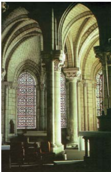
Fotos 1 y 3.—El deambulatorio de St. Denis (1) empezado en 1140, obedece a la misma concepción estructural que el de St. Germer-de-Fly (3) que es cinco años anterior, contando ambos con los mismos elementos arquitectónicos y con una ejecución muy similar. Sin embargo, St. Denis es más amplio (doble ambulatorio) y recibe mucha más luz debido a la amplitud de sus ventanales. Por esa razón y la belleza de sus proporciones, es considerada como una obra maestra y novedosa de su tiempo.
